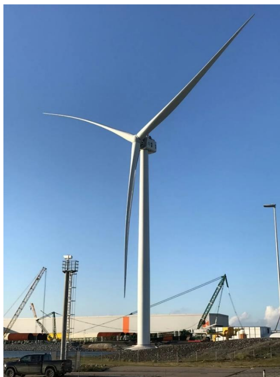
Εικόνα 2.14: Πρωτότυπο του μοντέλου Haliade-X 14 MW της General Electric εγκατεστημένο στο λιμάνι του Ρότερνταμ για δοκιμές (General Electric).
