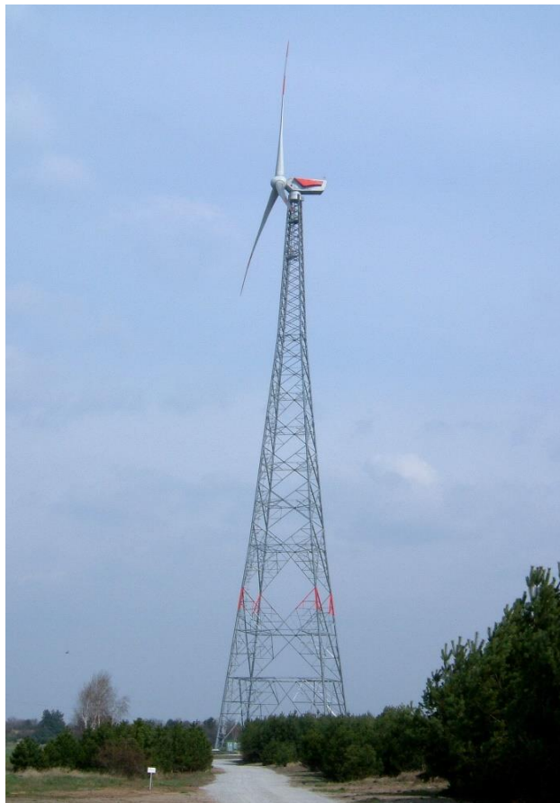
Εικόνα 3.6: Δικτυωτός πύργος Α/Γ στη Γερμανία (SPBer, 2007).
