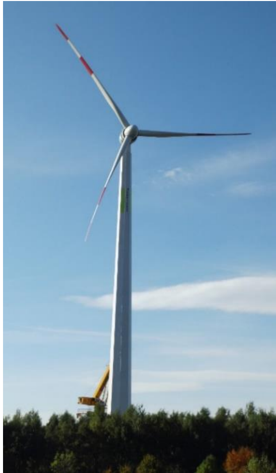
Εικόνα 3.12: Ξύλινος πύργος ύψους 100 μέτρων στο Αννόβερο Γερμανίας.
