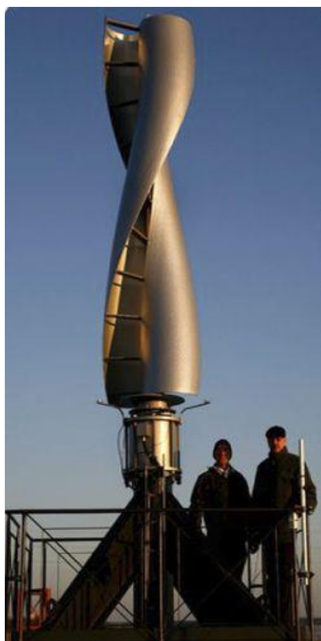
Εικόνα 2.8: Α/Γ κατακόρυφου άξονα με ελικοειδή ρότορα Savonius (ArchiEXPO, 2021).
