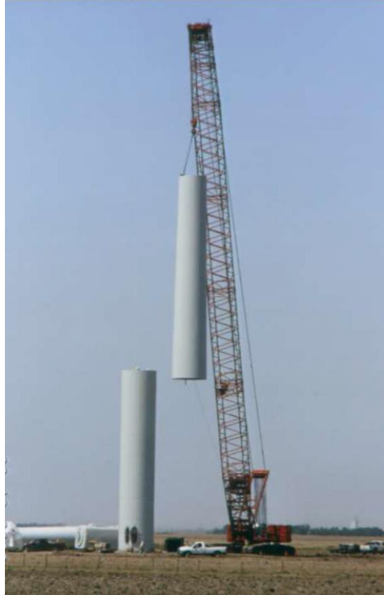
Εικόνα 3.3: Ανέγερση σωληνωτού πύλωνα (Lotfy, 2012).
