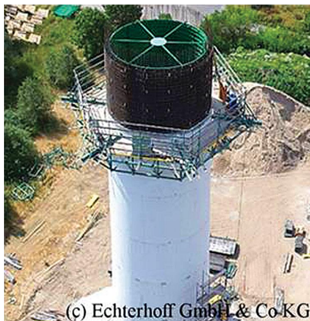
Εικόνα 3.7: Τοποθέτηση αναρριχόμενου ξυλότυπου (Von Der Haar & Marx, 2015)
