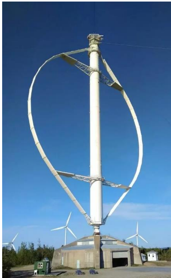
Εικόνα 2.7: Éole : Η μεγαλύτερη Α/Γ κατακόρυφου άξονα, με ρότορα τύπου Darrieus (Tourisme Gaspésie).
