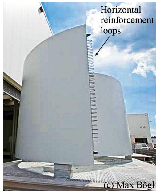
Εικόνα 3.8: Τμήμα κυλινδρικής διατομής σκυροδέματος όπου φαίνονται τα οριζόντια αγκύρια (Von Der Haar & Marx, 2015).
