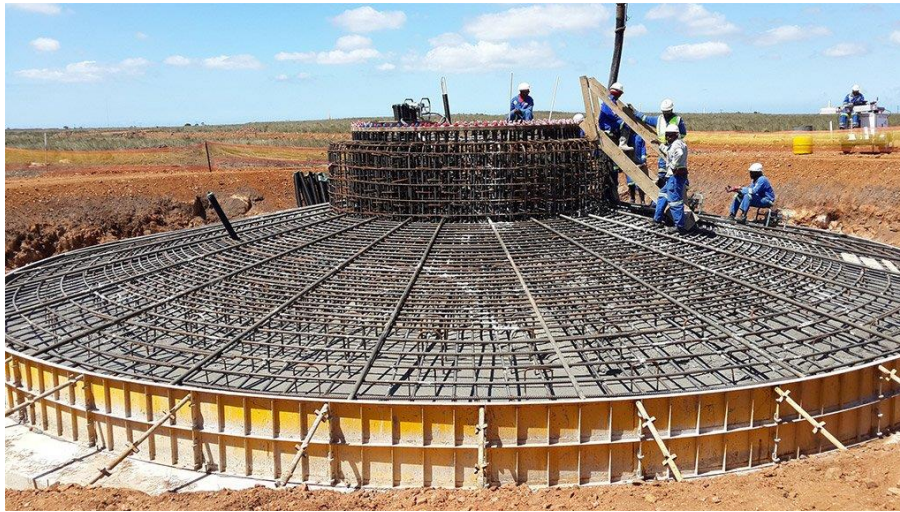
Εικόνα 2.11: Πέδιλο θεμελίωσης σωληνωτού πυλώνα Α/Γ υπό κατασκευή (Van Wyngaardt, 2014).
