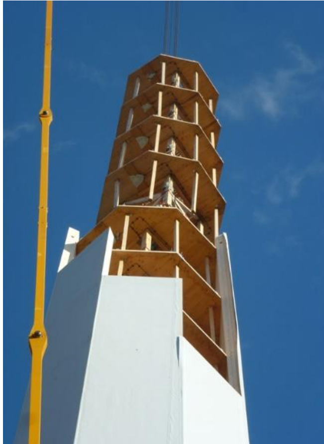
Εικόνα 3.13: Τοποθέτηση των φύλλων περιμετρικά του σκελετού σε ξύλινο πύργο (Quick, 2012).
