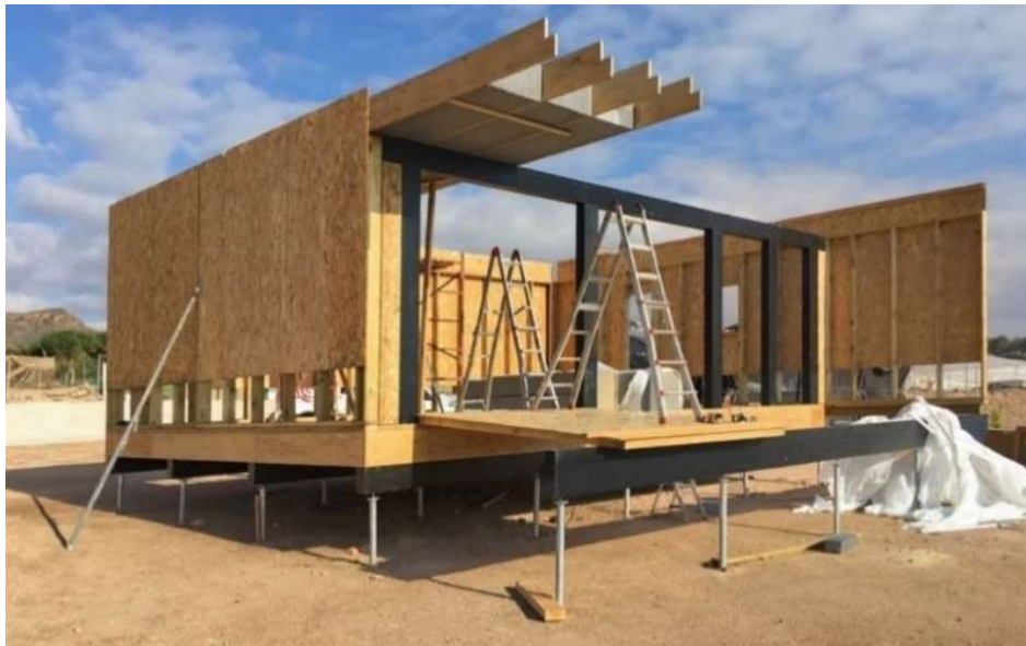
Ilustración 1. Construcción de una vivienda con entramado ligero
