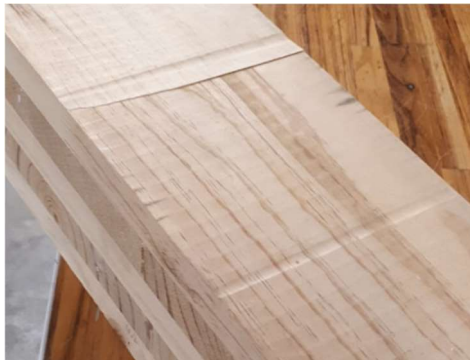
Ilustración 21. Holguras en la cara superior
