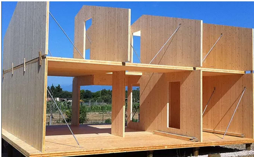
Ilustración 14. Edificio de CLT con muros portantes
