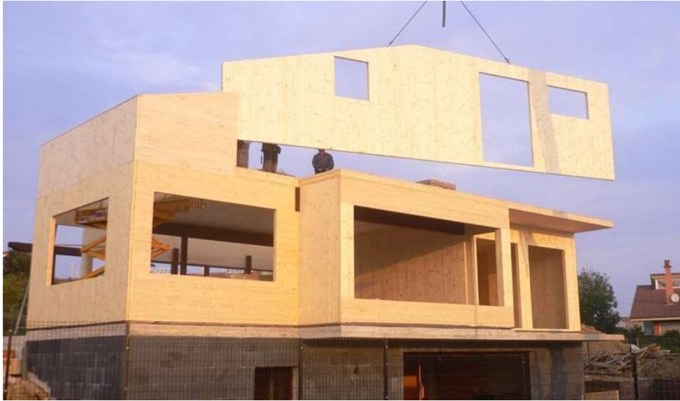
Ilustración 2. Construcción con paneles CLT realizada por Egoín
