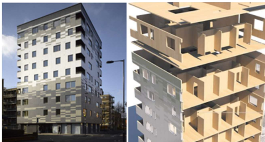
Ilustración 5. Edificio Stadthaus en Londres
