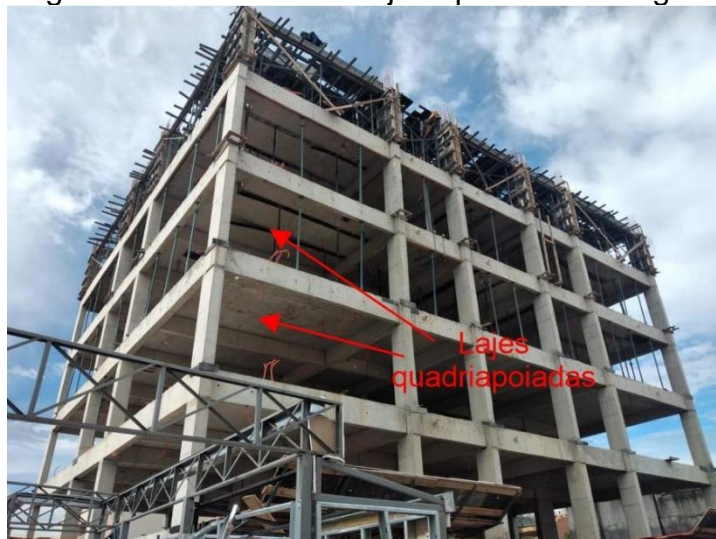
Figura 1: Estrutura com lajes apoiadas em vigas.
