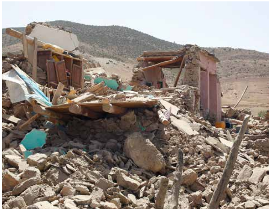
Fig. 2.5 Destrozos en la aldea de Tafagajt, en Marruecos, cerca del epicentro del devastador terremoto que azotó Marruecos el pasado día 8 de septiembre de 2023. (Fotografía de María Traspaderne para EFE)
