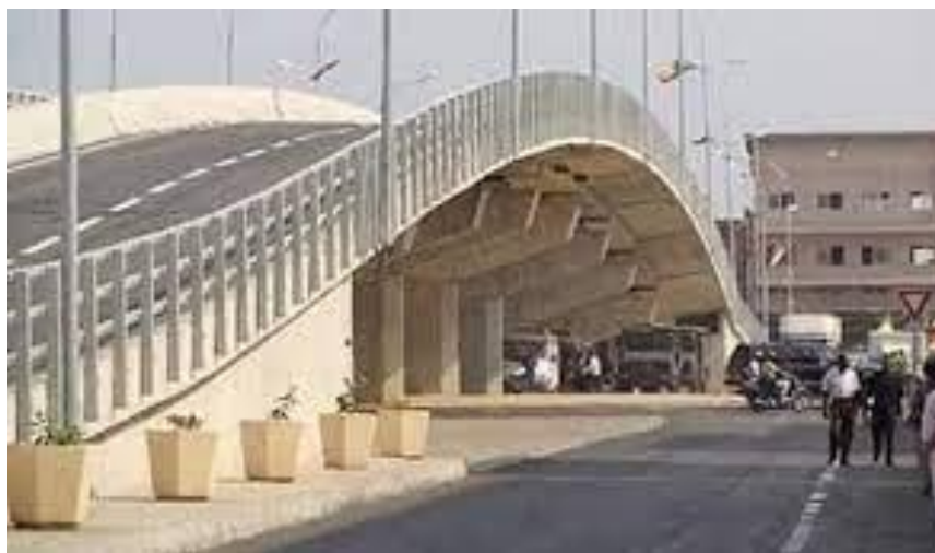
Photo 7 : Le passage supérieur de Houeyiho
